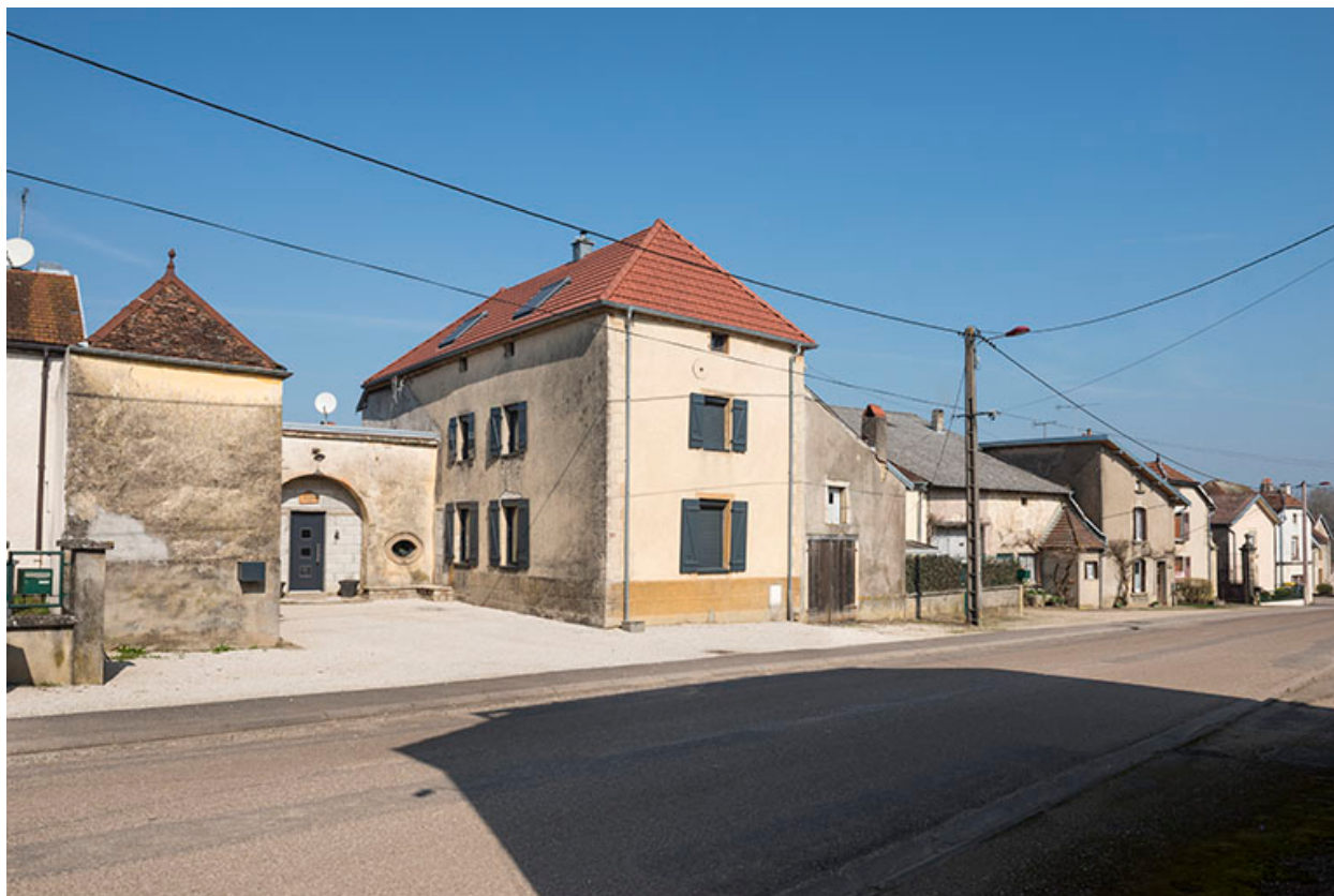
Vue générale, Grande rue.
