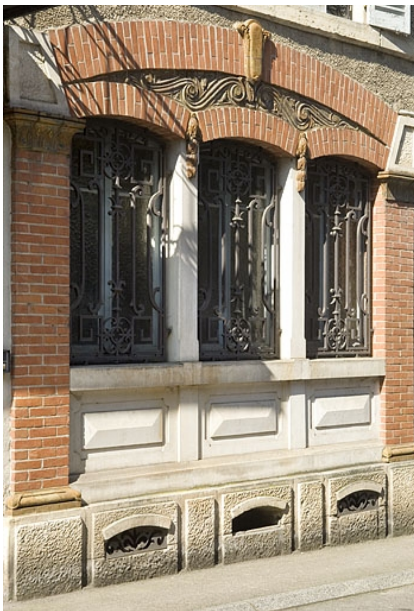
Détail d'une baie triple.
