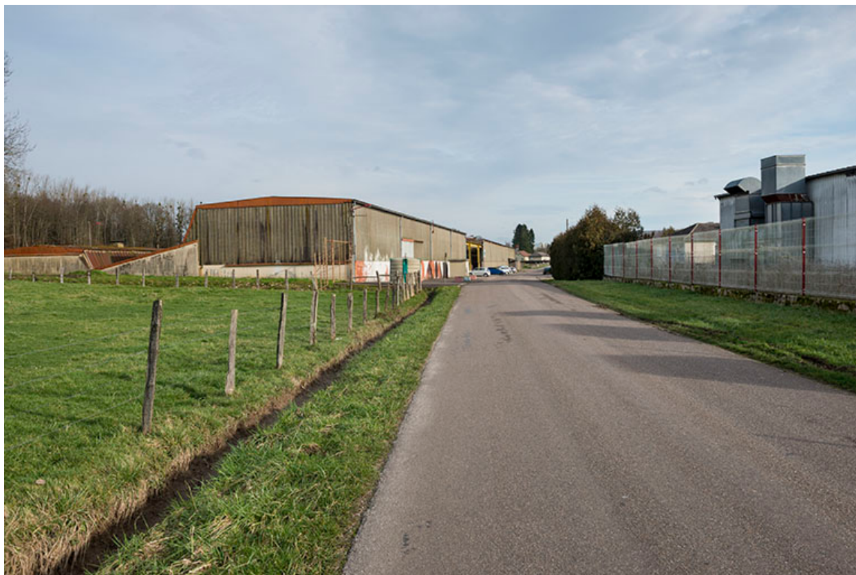
Vue du site depuis le sud-ouest.
