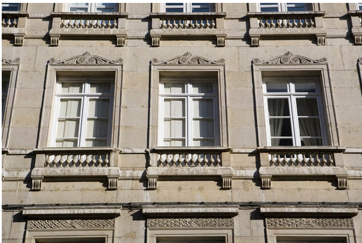
Détail des fenêtres du premier étage.
