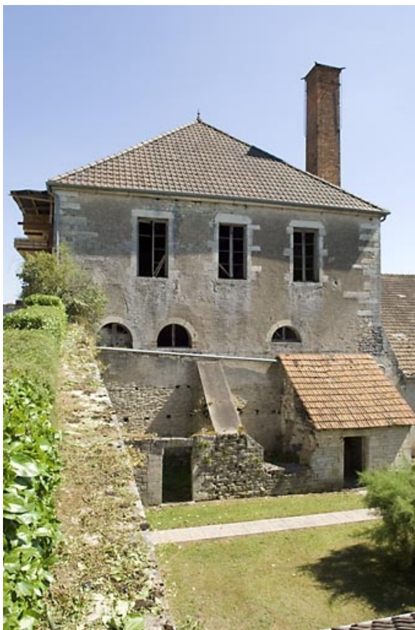
Façade nord-ouest du haut fourneau.
