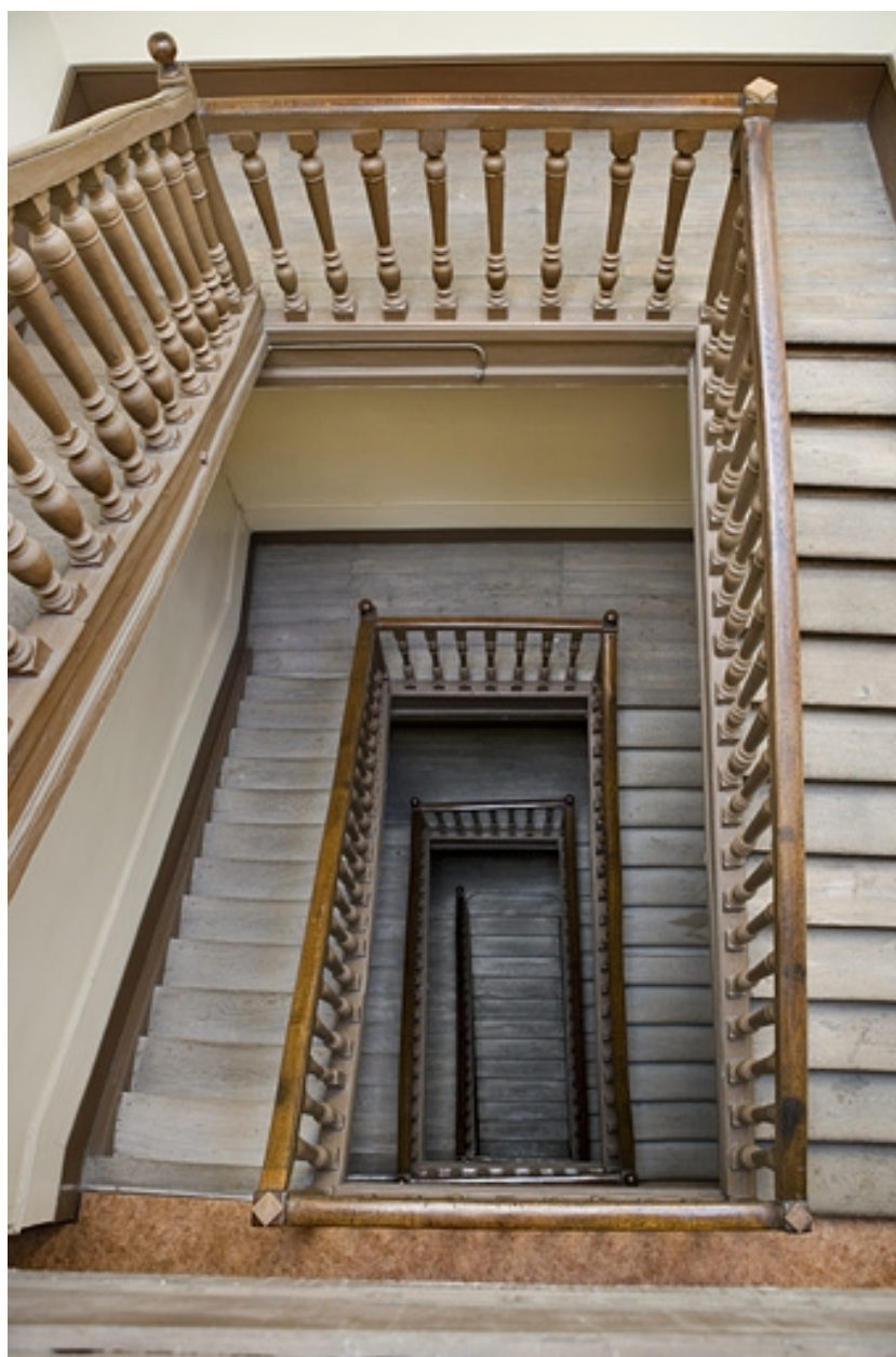
Vue d'ensemble de l'escalier.
