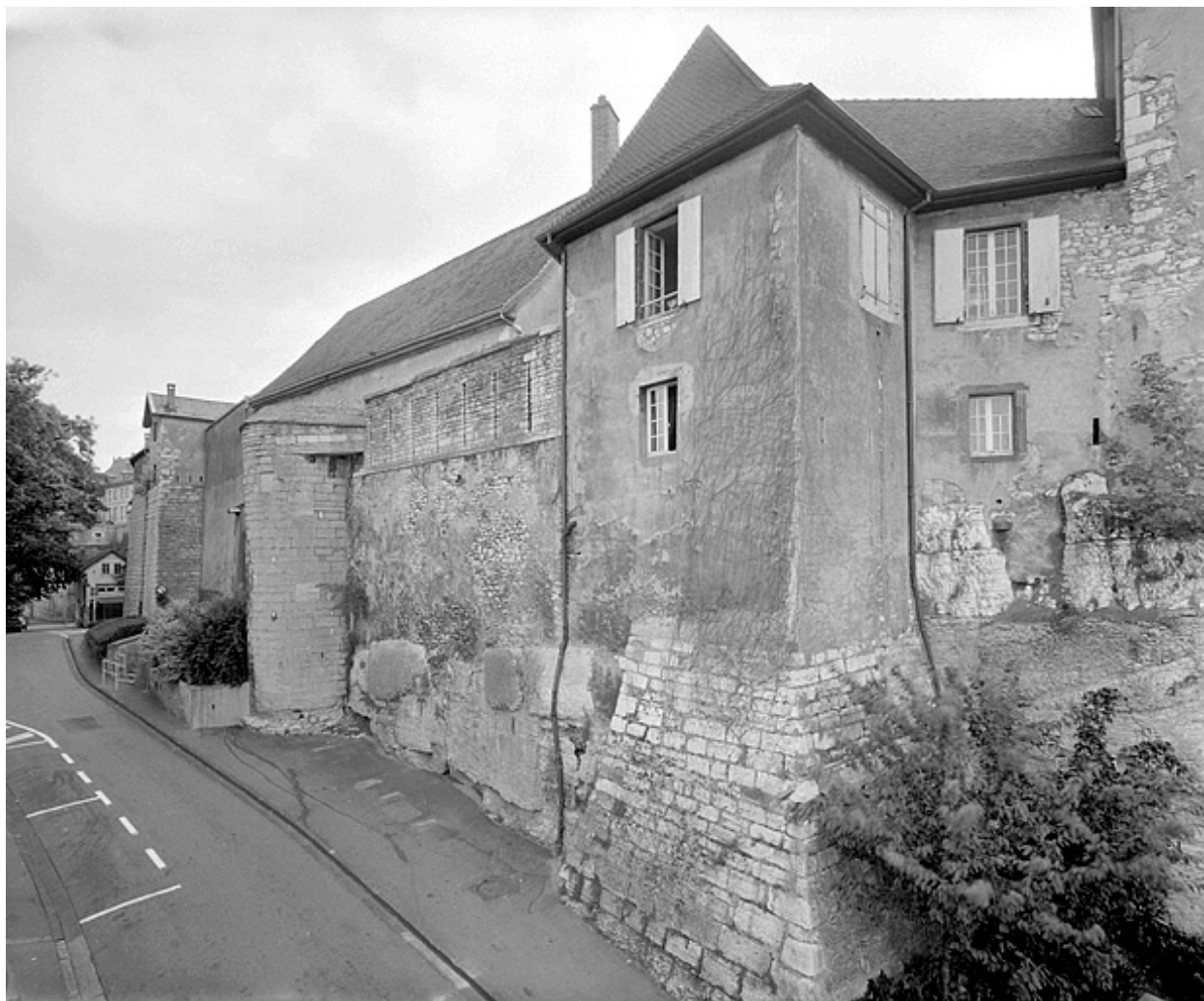
Enceinte. Partie près de la porte (d).
