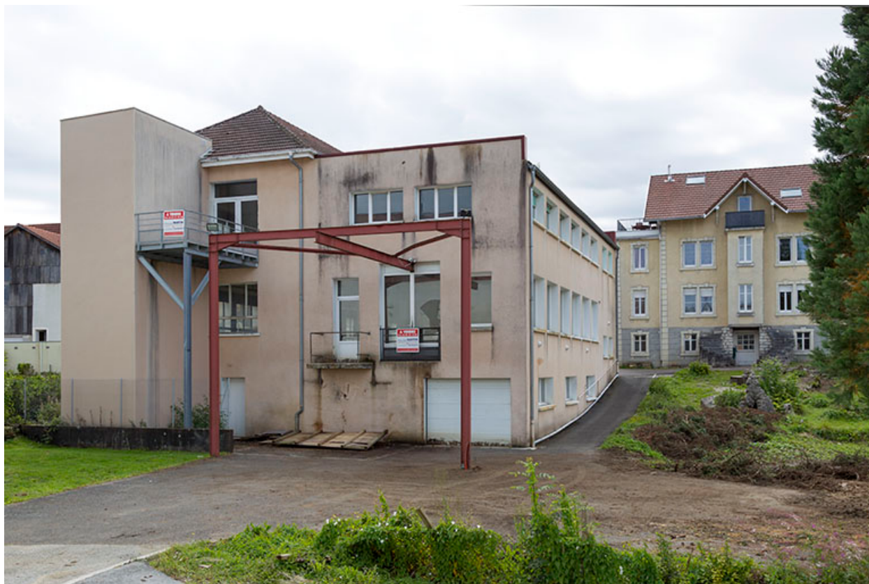
Usine : façade postérieure, de trois quarts droite.
