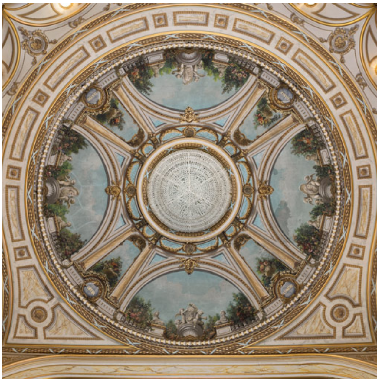
Plafond : vue d'ensemble.
