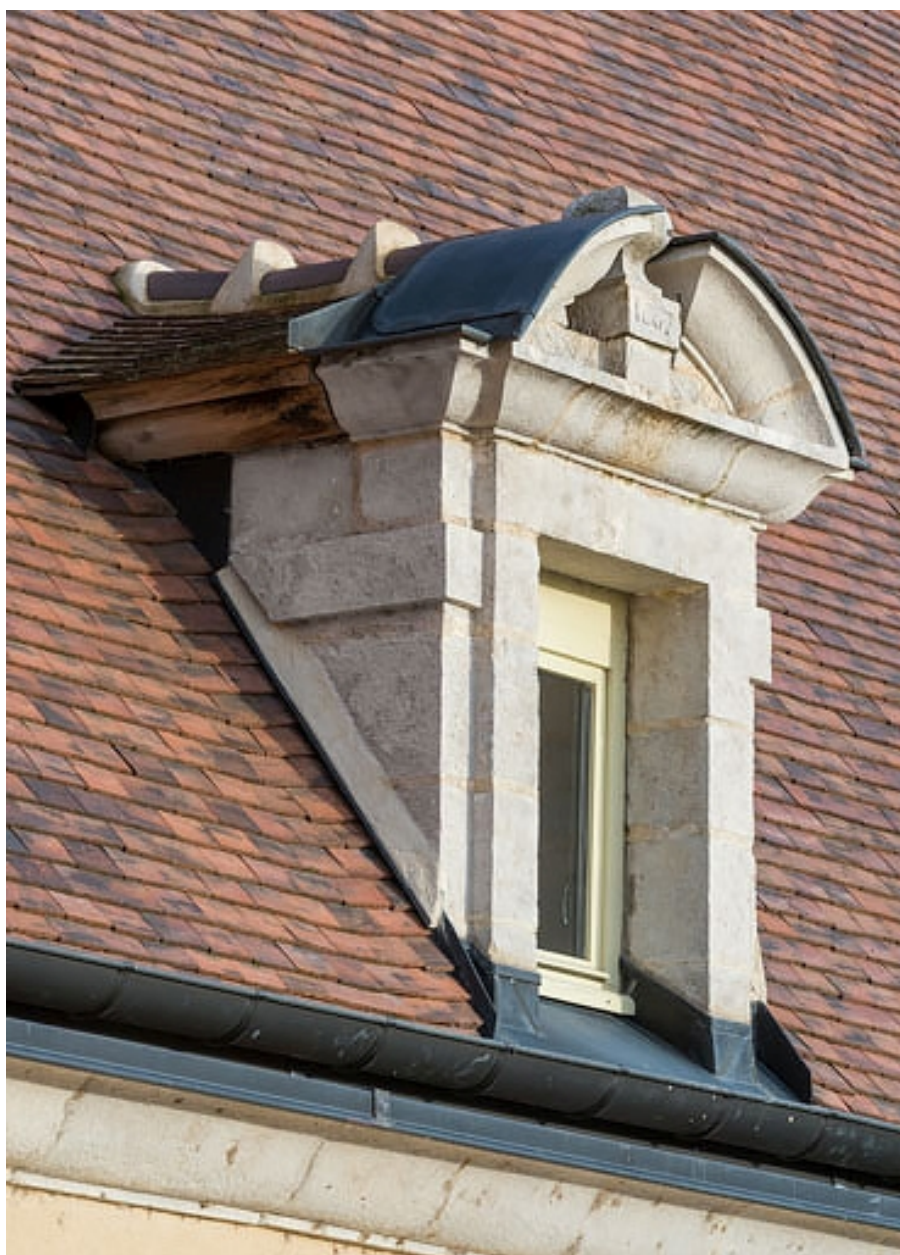
Aile est, façade antérieure : lucarne centrale.
