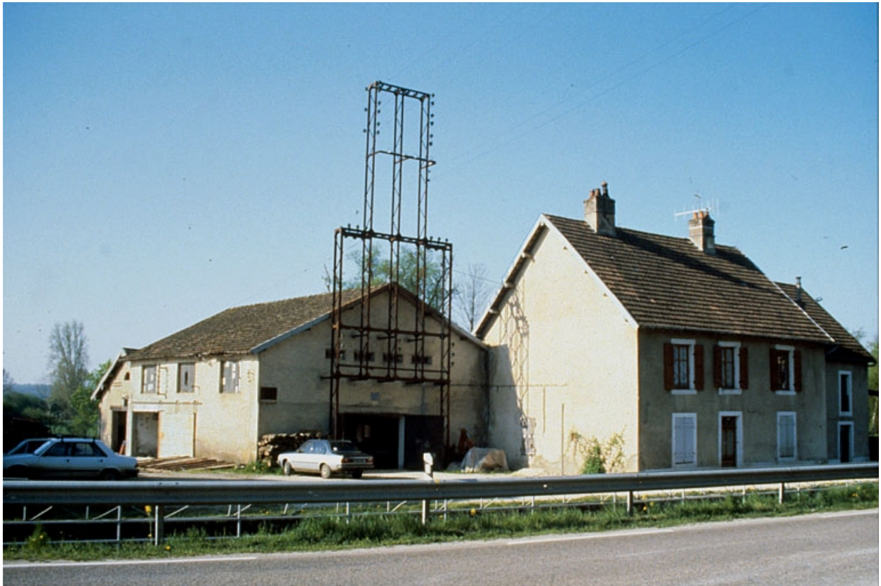
Centrale et maison vues du nord.
