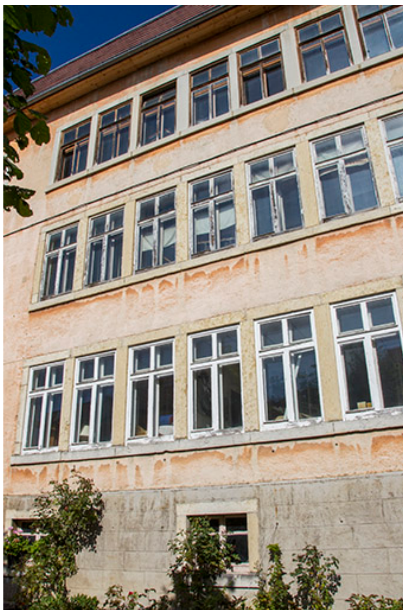
Usine : façade antérieure, vue en contre-plongée.
