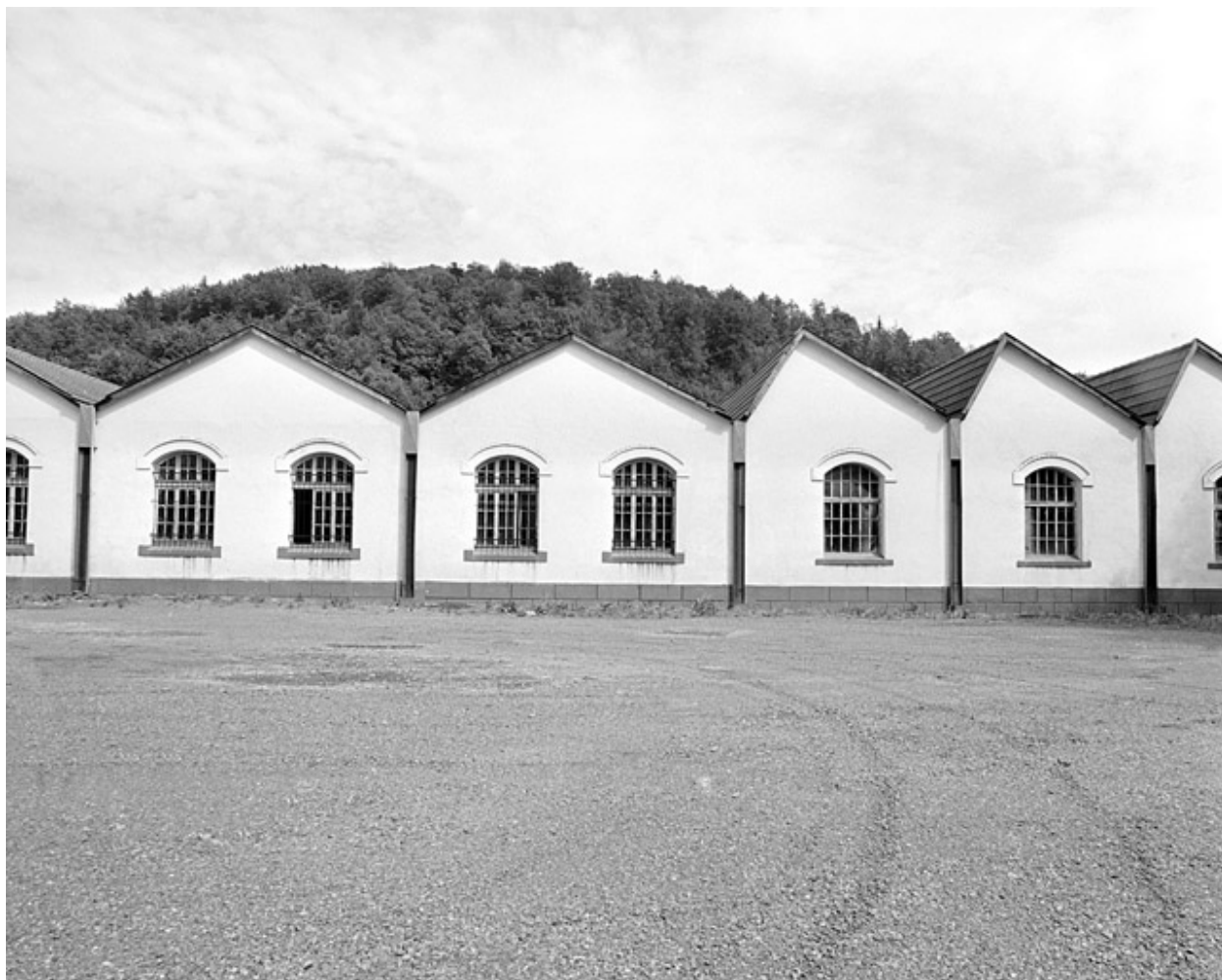
Murs-pignons de l'atelier de fabrication.
