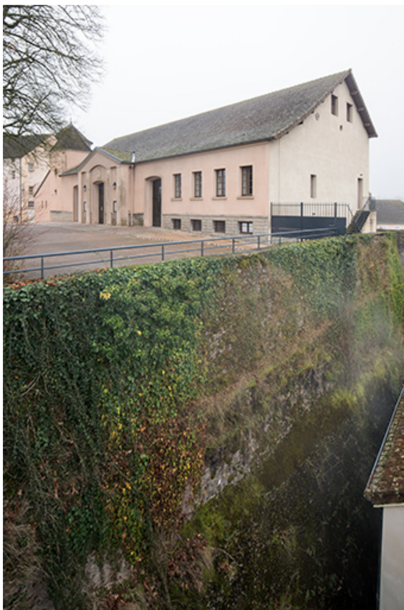
Façades antérieure et latérale droite.
