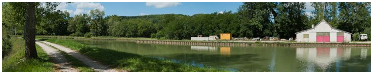
Vue d'ensemble du port.
