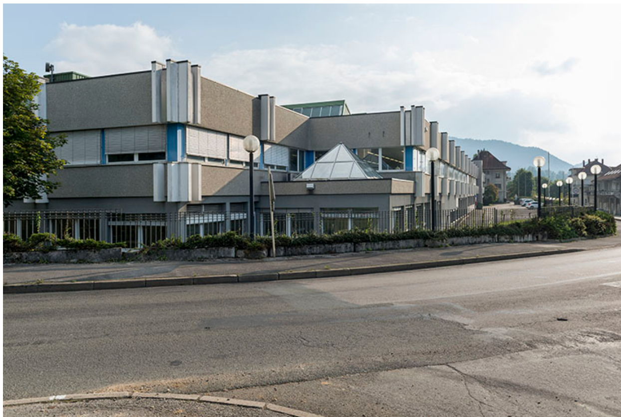
Façades nord et ouest.
