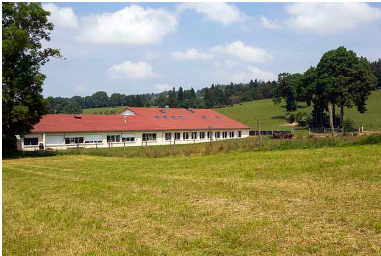
Façade postérieure (sud), de trois quarts gauche.
