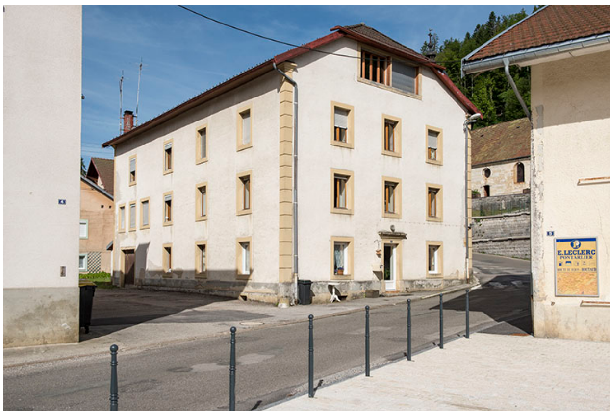
Façades antérieure et latérale gauche.
