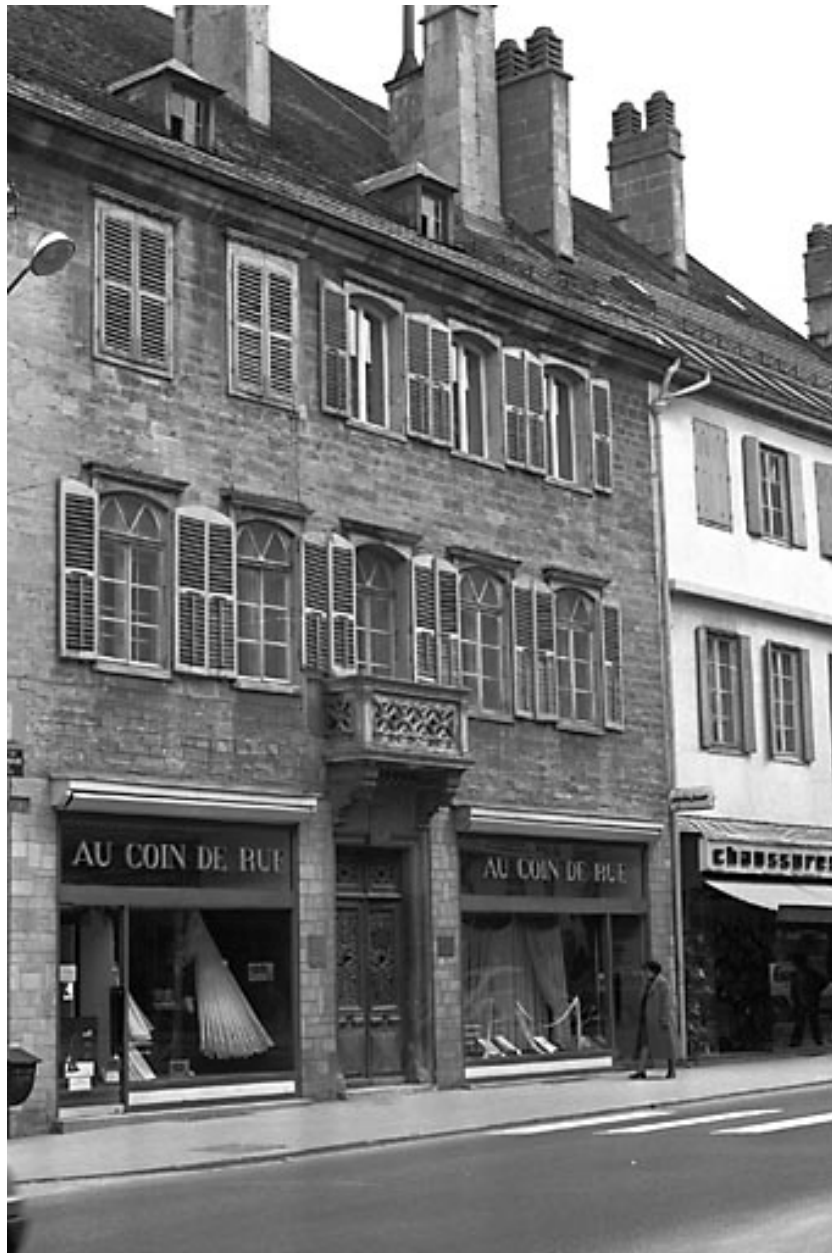
Façade sur rue de trois quarts gauche.
