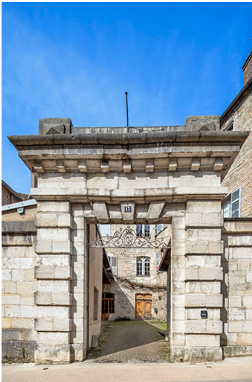
Porte monumentale de la cour.
