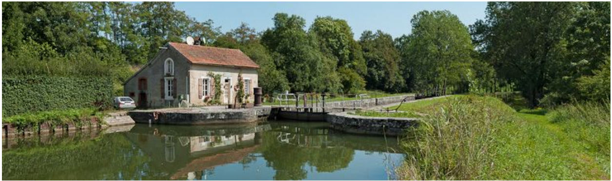
Vue du site d'écluse.
