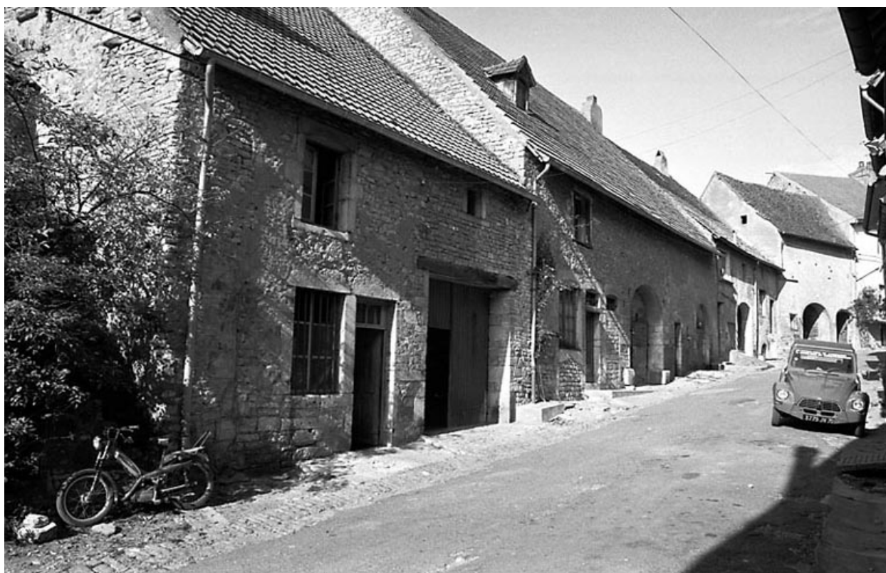
Ferme située rue Bizot.
