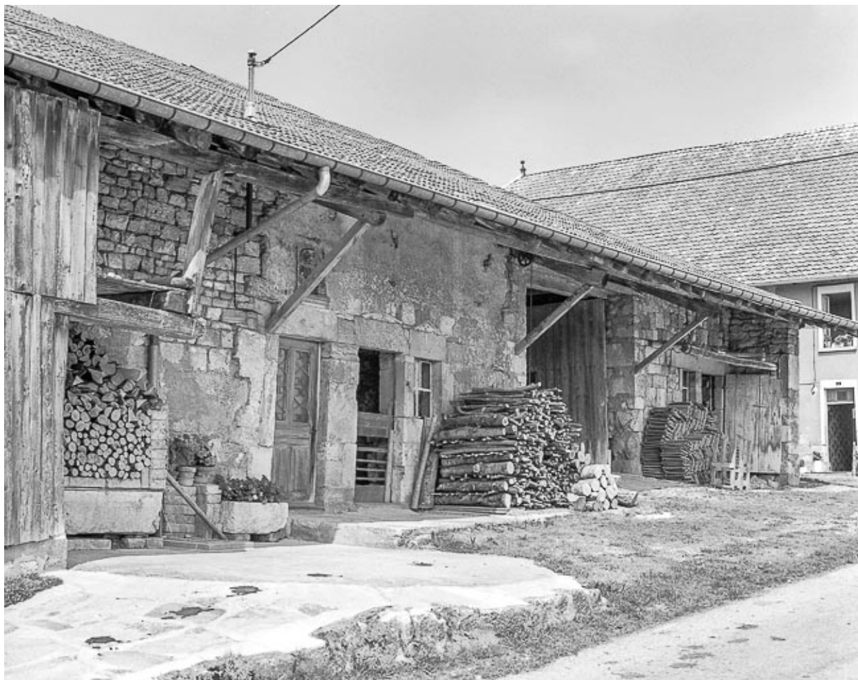
Ferme : gutterot sur rue.
