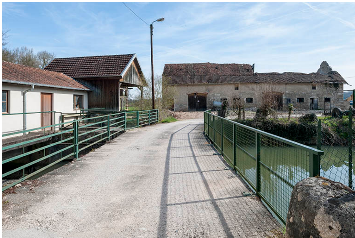
Centrale hydroélectrique (à gauche) et bâtiment agricole.
