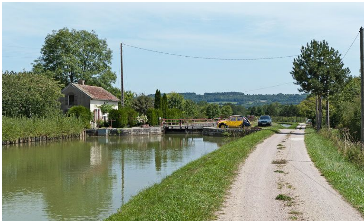
Vue du site d'écluse depuis l'amont.
