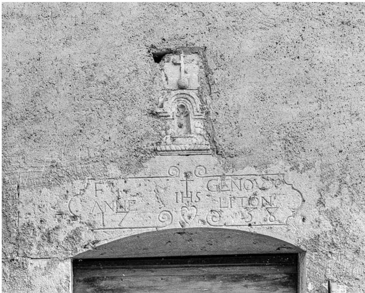
Détail de la porte d'habitation.
