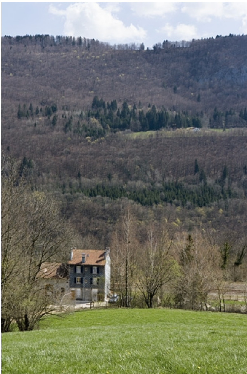
Vue d'ensemble du site, depuis le nord-ouest.
