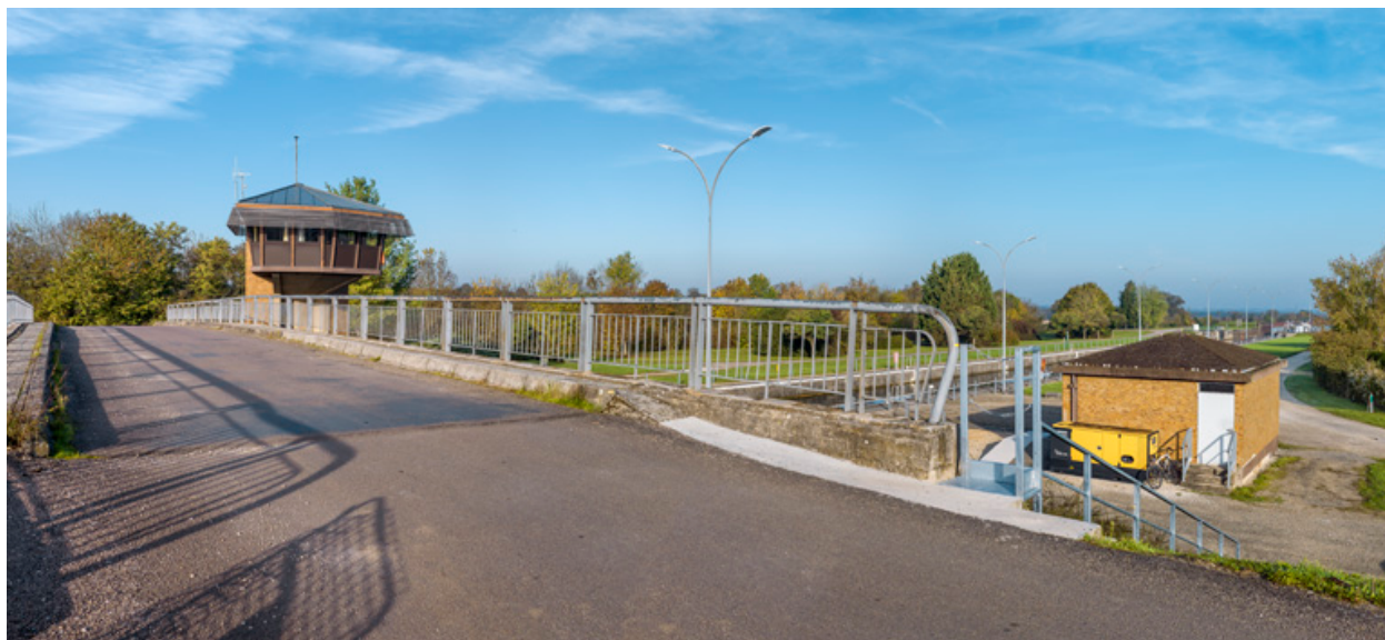
Vue d'ensemble depuis le pont sur écluse.
