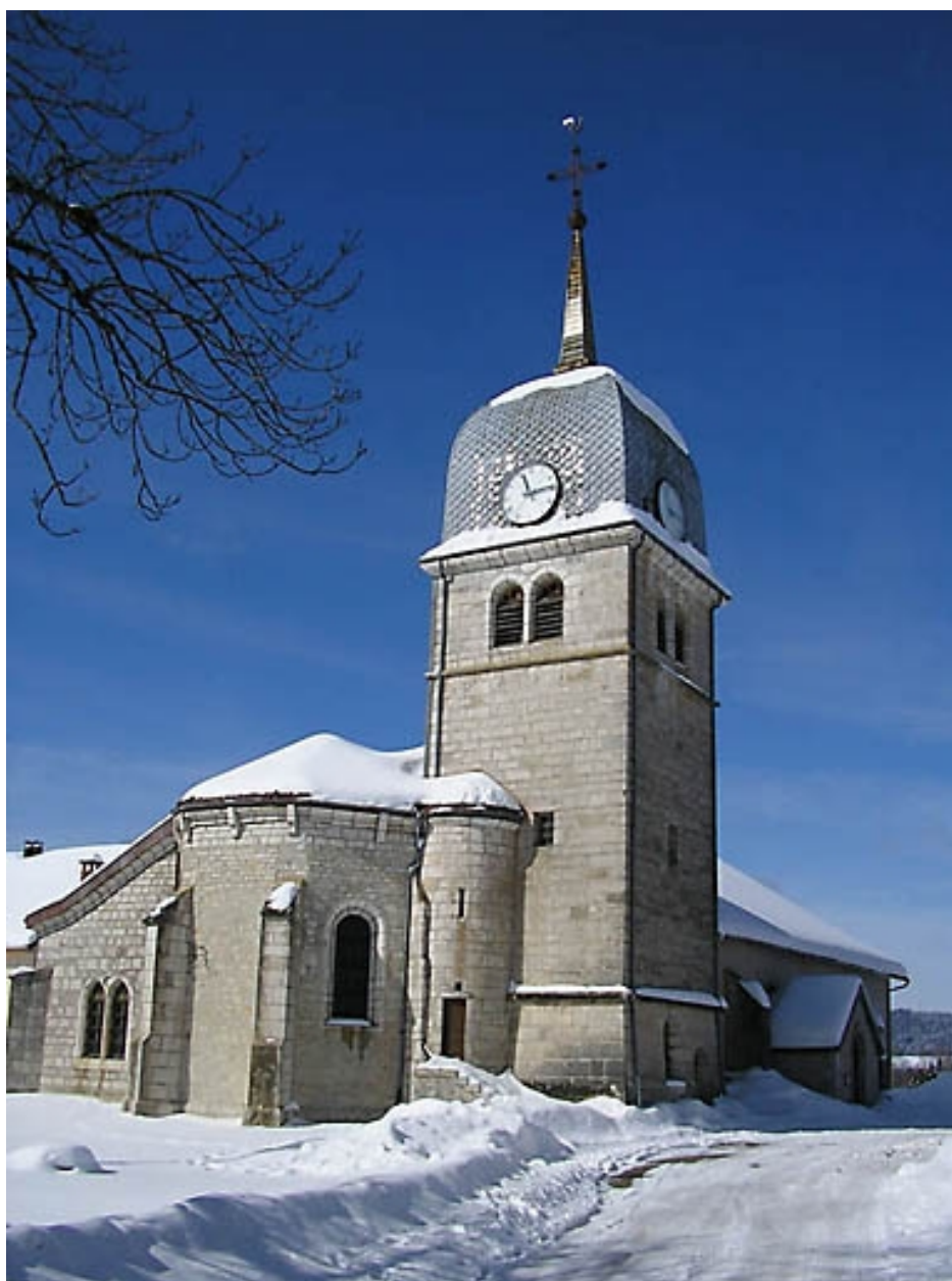
Vue générale de l'abside et du clocher.
