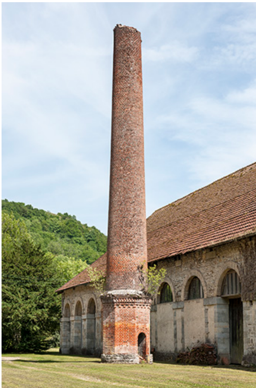
Cheminée de la tuilerie.
