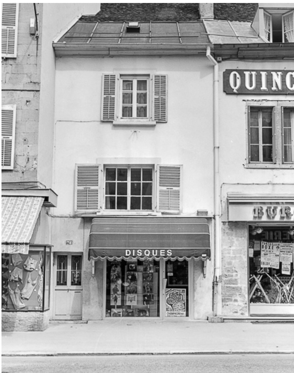
Façade sur rue, vue de face.
