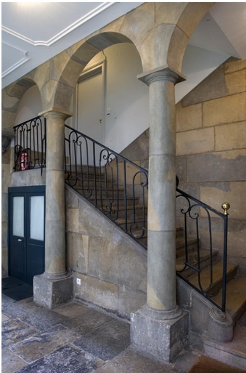
Vue d'ensemble de l'escalier.
