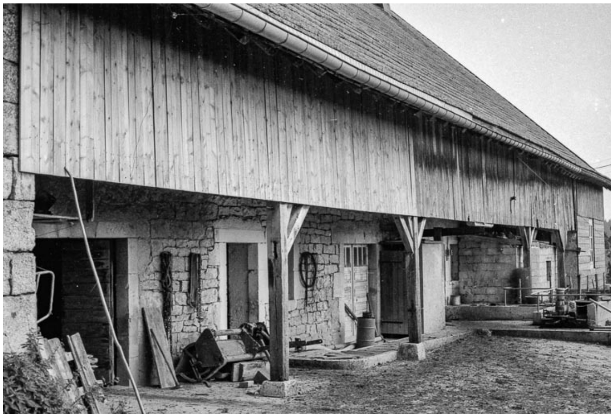
Mur gouttereau gauche.
