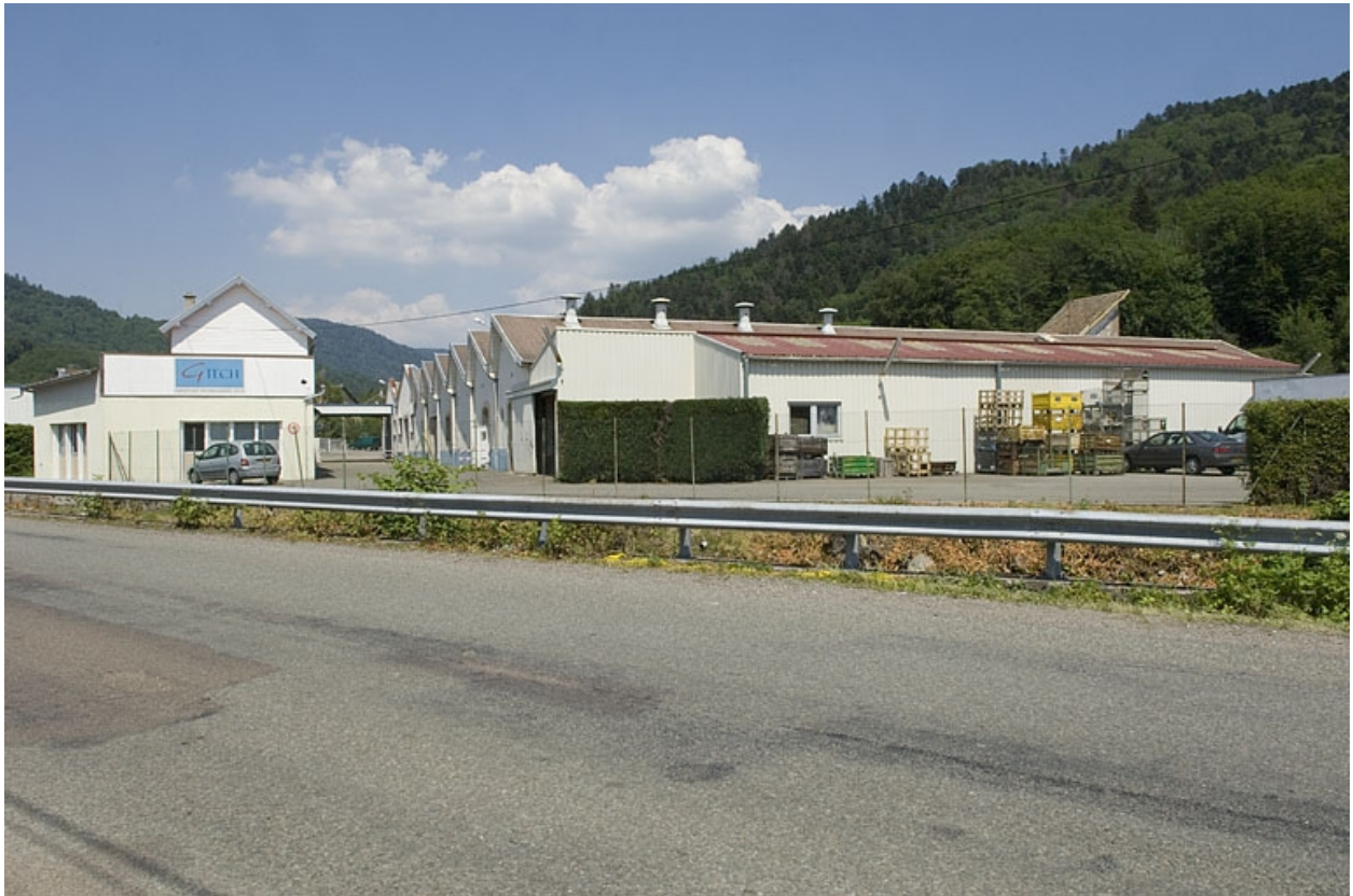
Vue d'ensemble depuis la route, au sud.
