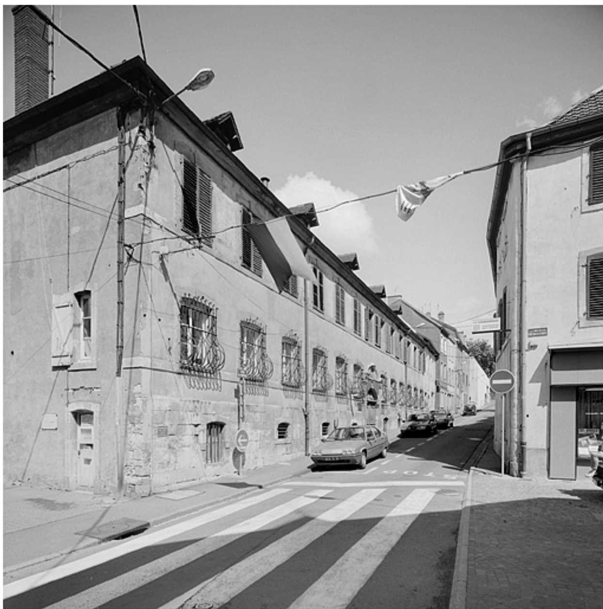
Façade sur la rue du Château.
