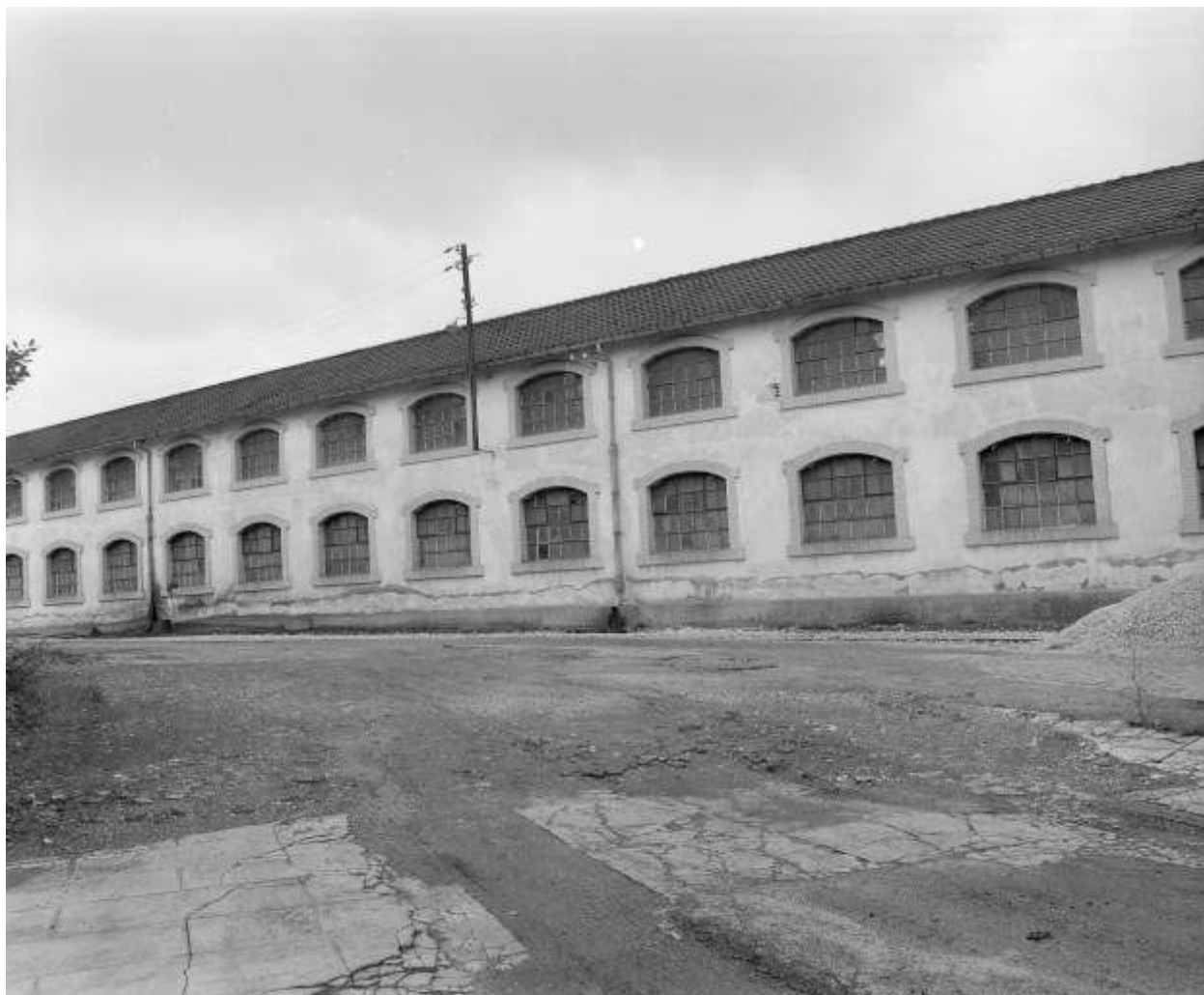
Façade nord de l'atelier des pompes en 1981.
