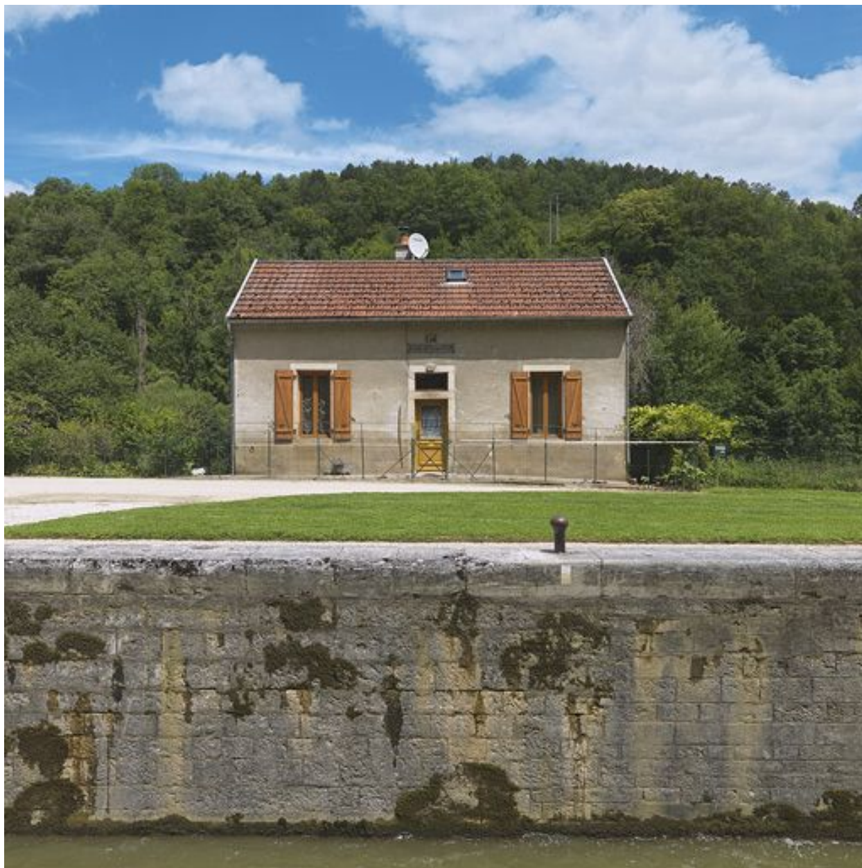
Maison éclusière de face.
