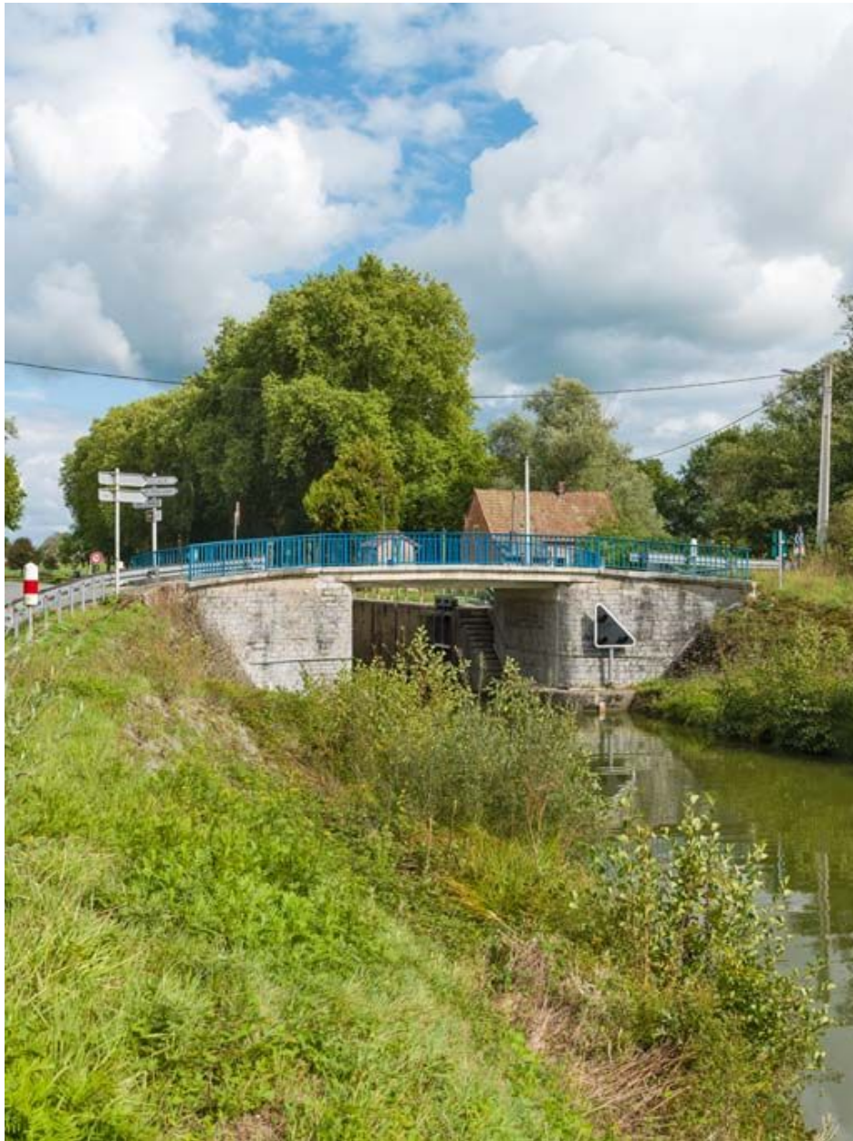
Vue d'ensemble du pont.
