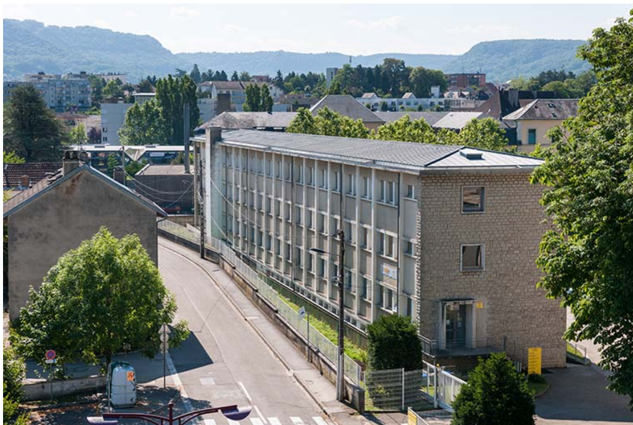
Vue trois quart de l'externat, ancien GRETA.
