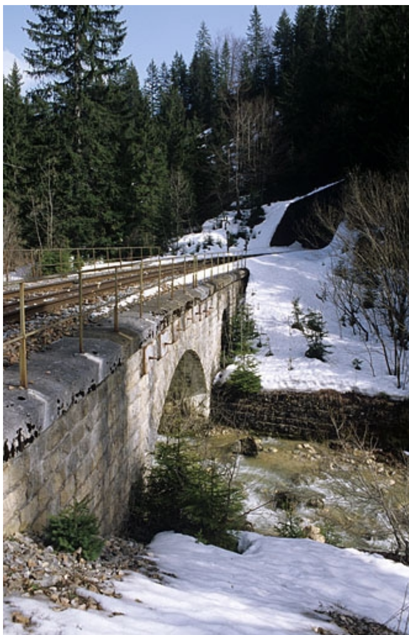
Vue d'ensemble, depuis le sud-ouest (aval).
