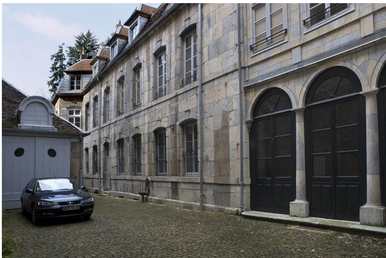
Vue d'ensemble de l' aile sur cour.
