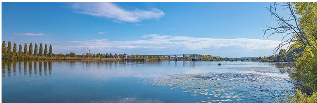
Le barrage, vu d'amont.
