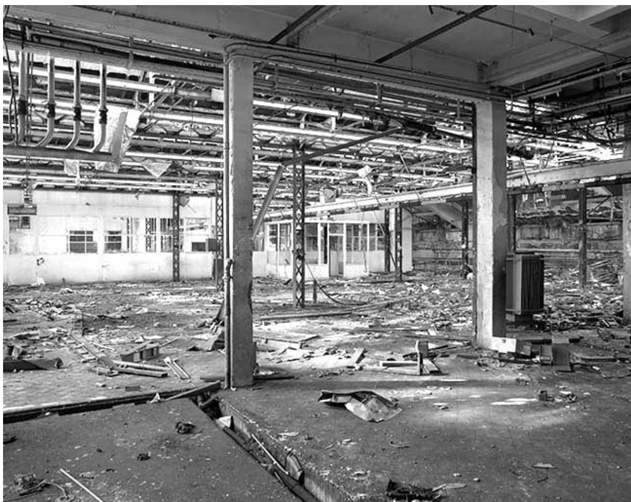
Intérieur du bâtiment (3).
