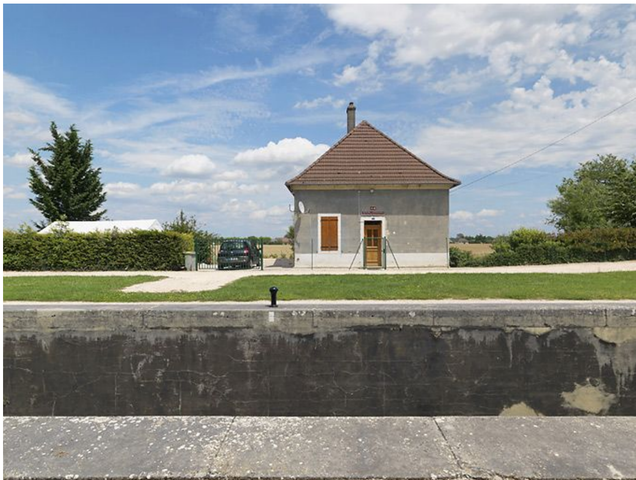
Maison éclusière vue de face.
