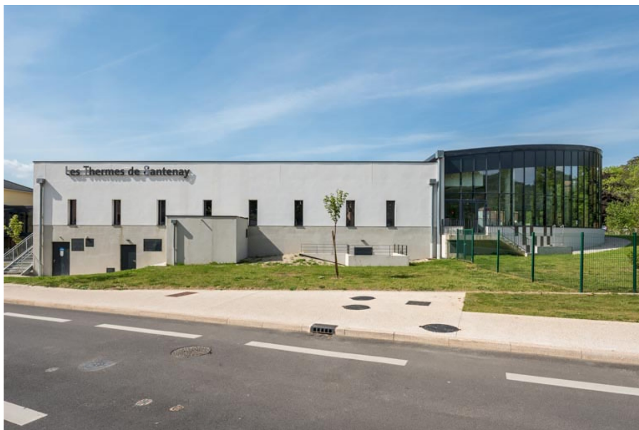
Vue depuis le nord-est.
