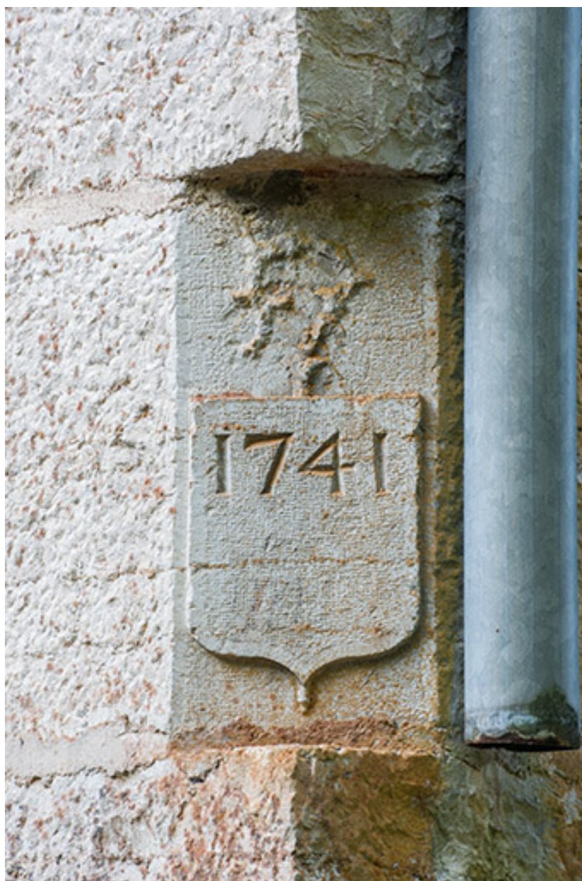
Moulin nord. Pierre d'angle nord-est.
