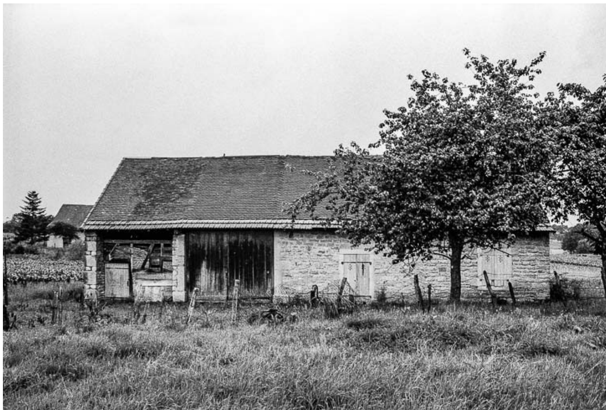
Ferme cadastrée 1969 AI 154 : façade antérieure.
