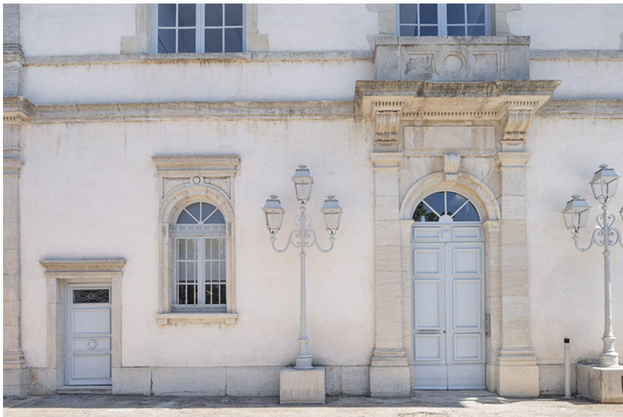
Façade postérieure : baies au rez-de-chaussée.
