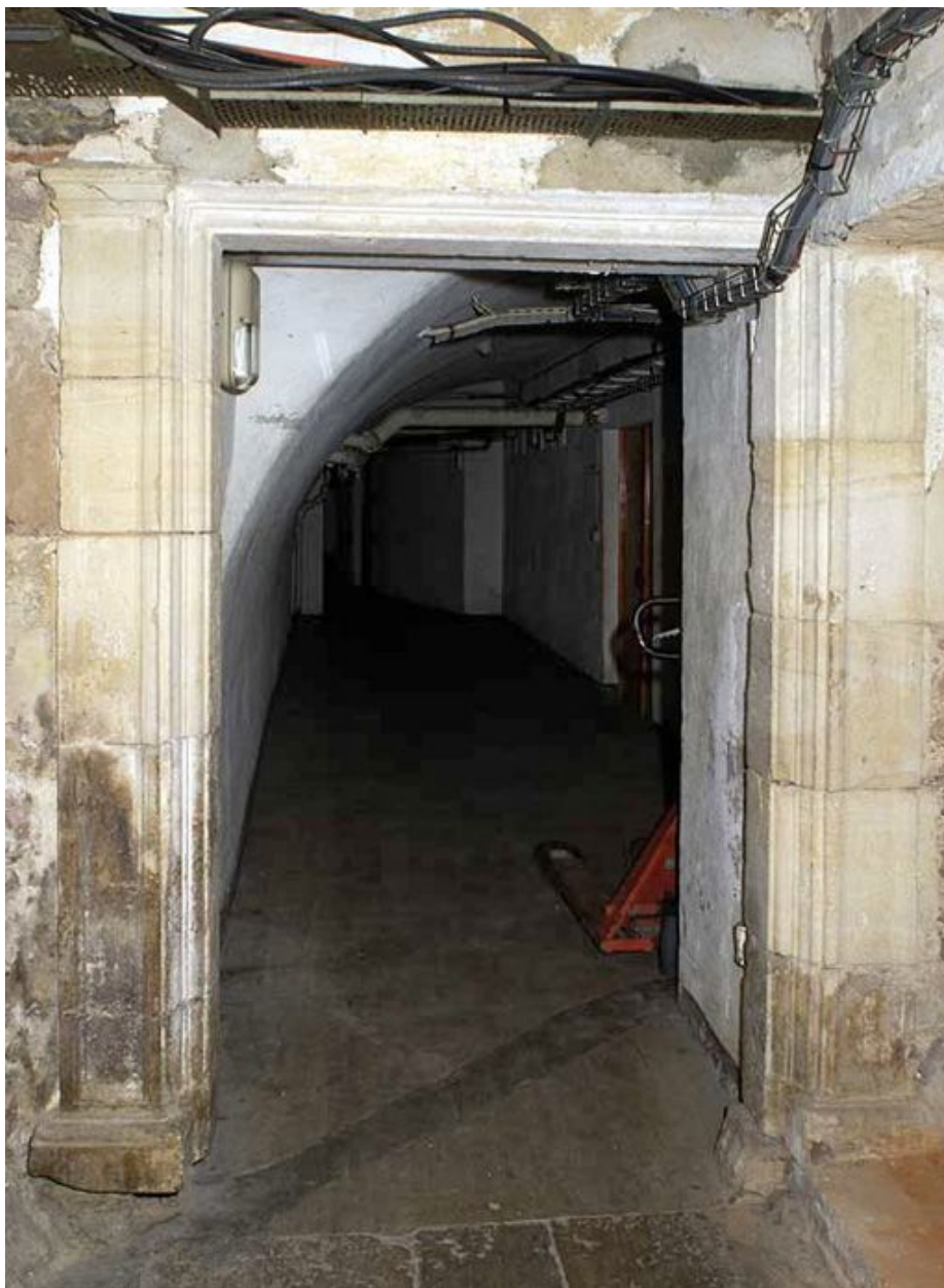
Ancien hôtel du gouverneur : sous-sol, porte.
