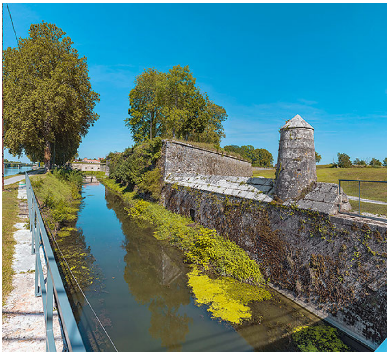
Le bastion et son batardeau.
